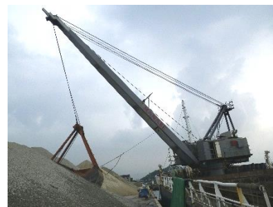
【バケットクレーン】
