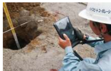
施工品質・精度向上のために 自社開発のタブレットアプリを使用中
