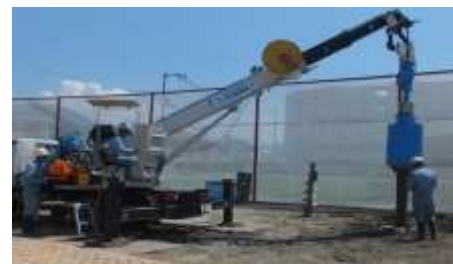
「ハイスピード工法」施工風景
